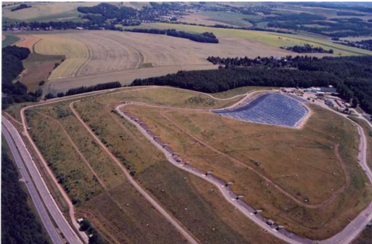
Bild 5: Deponie Weißer Weg (temporäre Zwischenabdeckung)
