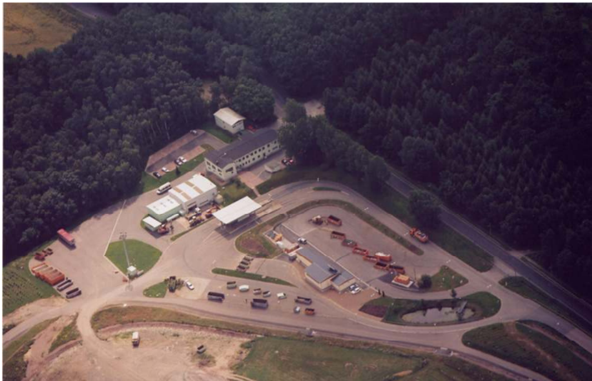
Bild 3: Umschlagstation oberer Teil
