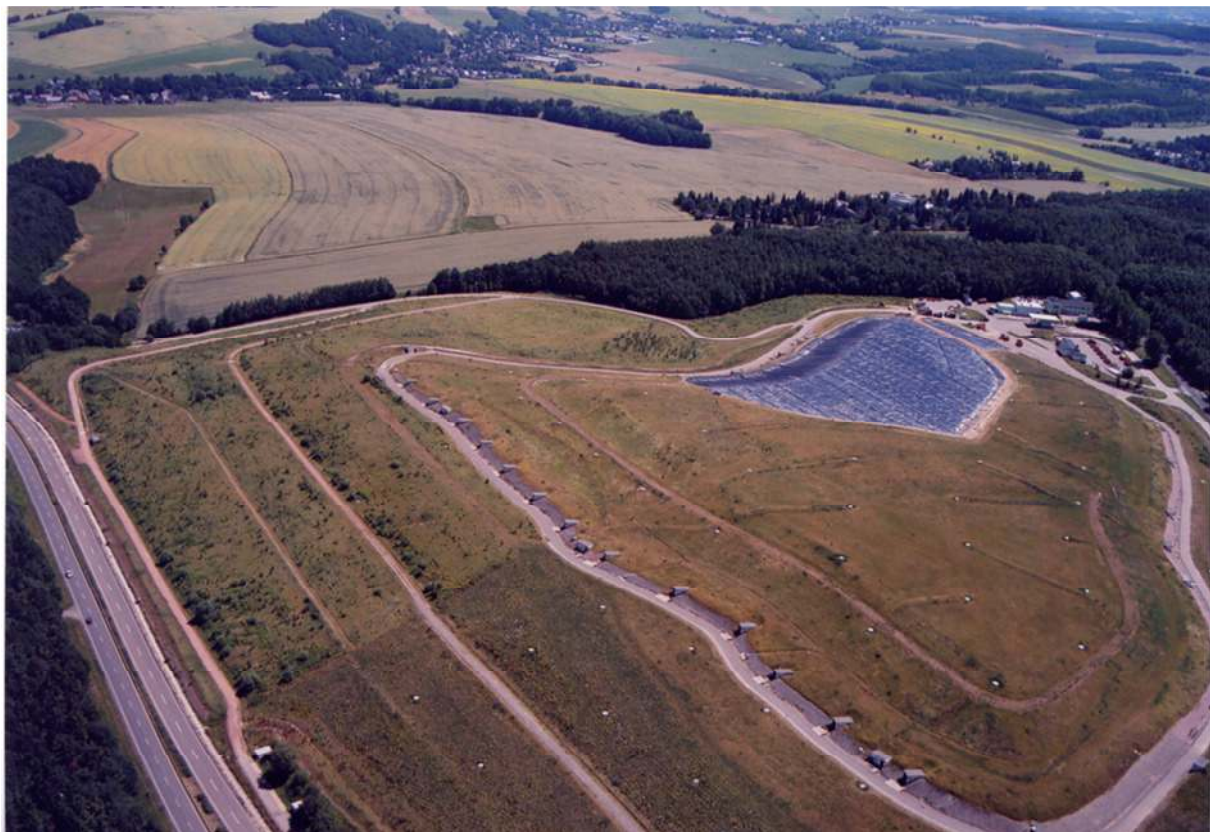
Bild 8: Deponie Weißer Weg (temporäre Zwischenabdeckung)
