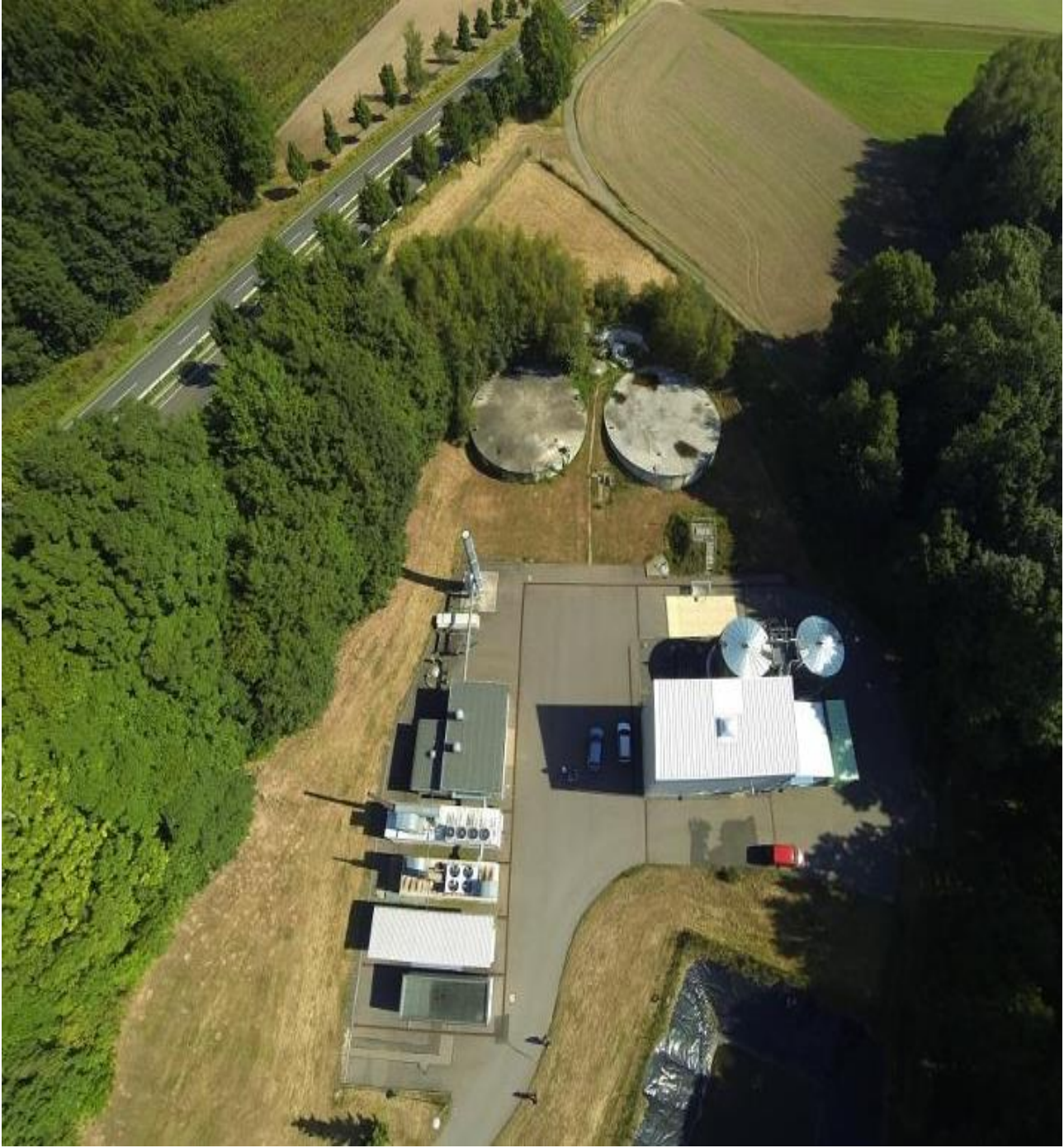
Bild 1: Standort Weißer Weg – Technische Anlagen
