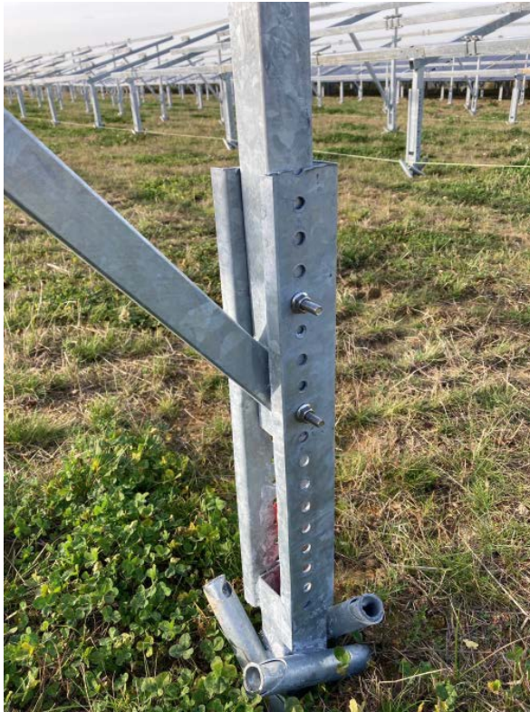
Abbildung 7 Unterkonstruktion mit schonender Verankerung, um die Deponieoberfläche nicht zu verletzen
