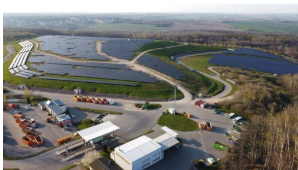
Abbildung 1 Sonnendeponie Weißer Weg (re: Ausbaustufe I von 2017; li: Ausbaustufe II von 2021), AWVC Chemnitz, nach Fertigstellung
