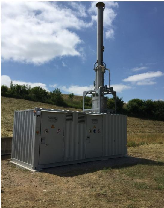
Die Schwachgasbehandlungsanlage hat ca. 120.000 m<sup>3</sup> Deponiegas mit einem durchschnittlichen Methangehalt von ca. 25,0 Vol.-% vom 11.07.2019 bis 31.01.2020 thermisch oxidiert.
